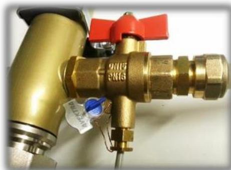
Рисунок 5. Пломба на шаровом кране.
