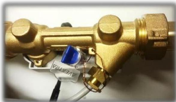
Рисунок 4. Пломба на проточной части.
